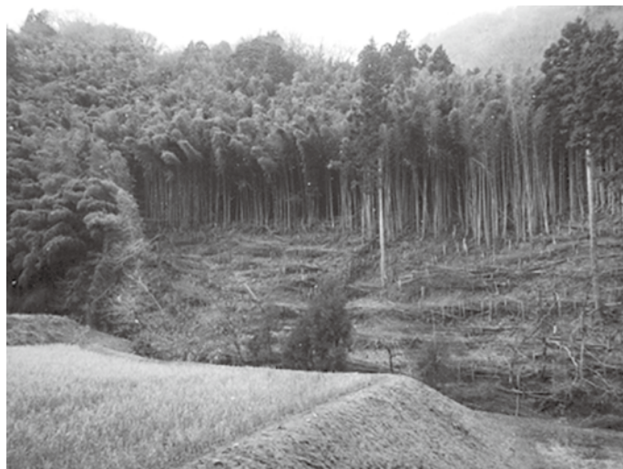
施工後(竹林伐採整備後)
