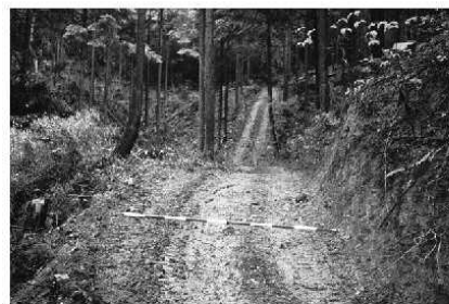
作業道整備（作業道の作設）
