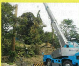
クレーンを使用した伐採
