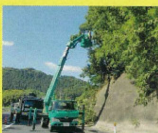
高所作業車を使用した伐採
