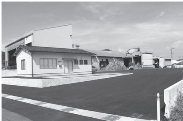
貯木場と検量管理棟
