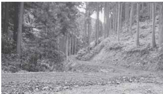
作業道開設状況
